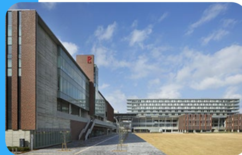
OIC A棟1階AS事務室内
